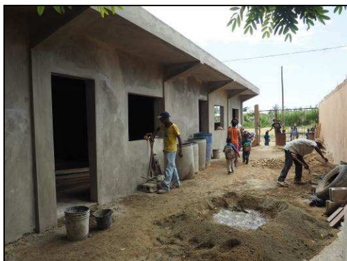
La scuola durante i lavori di ristrutturazione.
